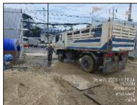
รูปที่ 2.2-6 จุดล้างล้อรถของโครงการ
